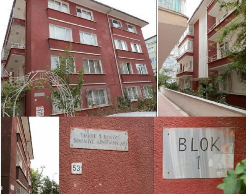
Şekil16.Yeşilyurt Sokak'taki İş Bankası ikramiye evleri (Fotoğraflar: Umut Şumnu)
