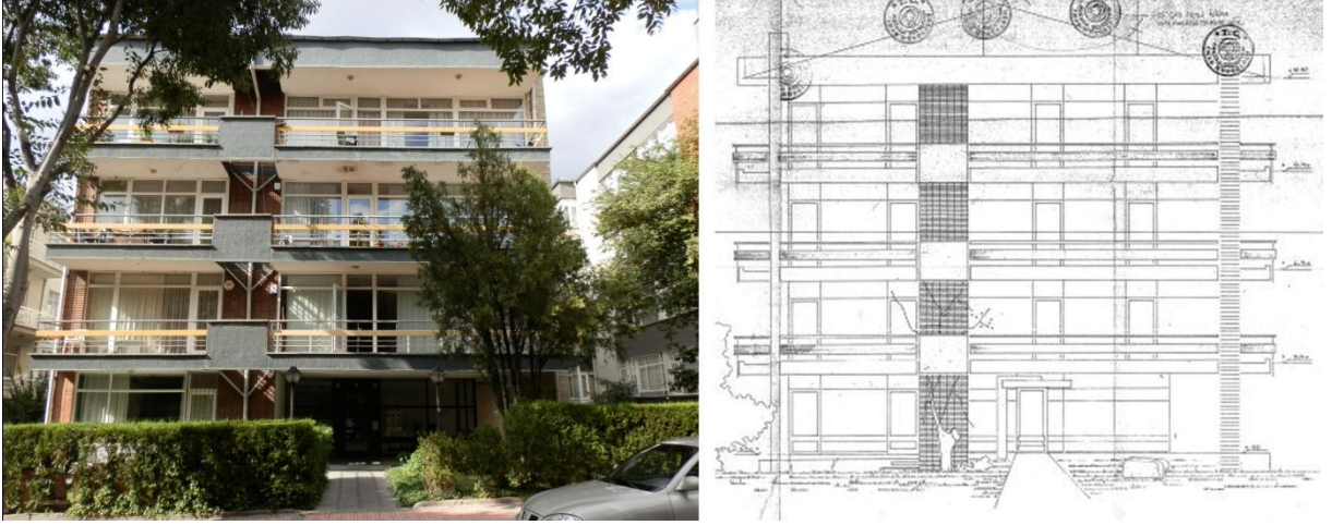
Şekil22: Apartmanlarının öncephe fotoğrafı (Fotoğraf: UmutŞumnu) Yapının ön cephe çizimi (Ankara BüyükşehirBelediyesi arşivi, Ada no: 5409, Parsel no :5, Adres: Ahmet Mithat Efendi Sokak 36/5, Proje onay tarihi: 13.08.1968, Proje: Lemi Varnalı)
