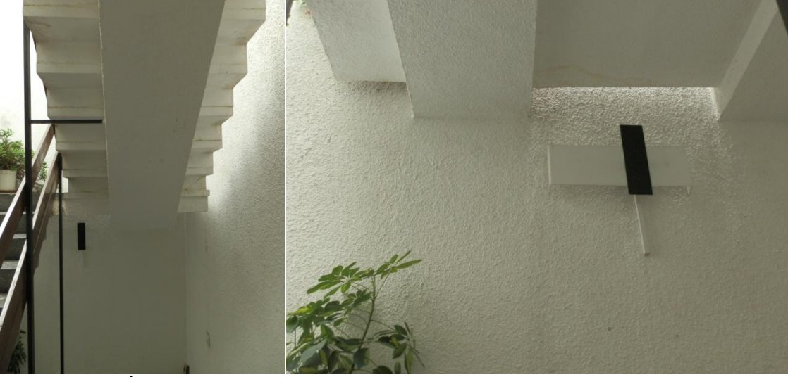
Şekil28: ÇankayaİşBankasıikramiyeapartmanlarınınmerdivenleri.Fotoğraf: Umut Şumnu.
